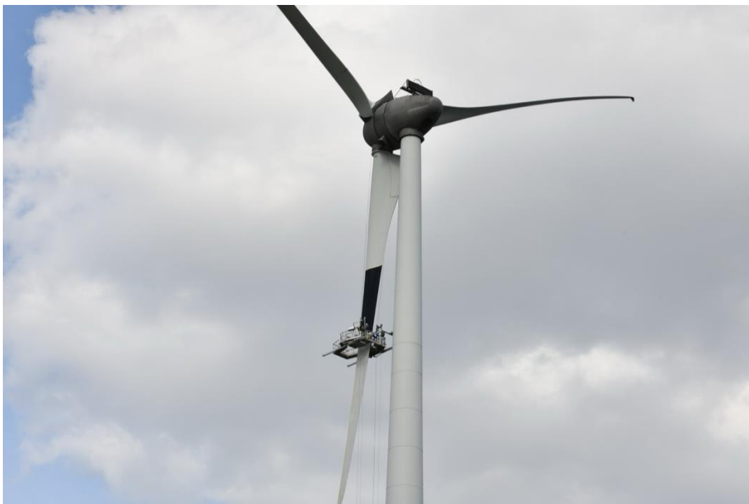
Figuur 4.1 Het zwart verven van een wiek in september 2022. Foto: Alex Wiersma, provincie Groningen.
