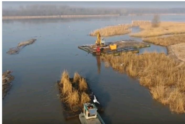
Figuur 4.18. Aanleg van rieteilanden in het Drontermeer. Gebruik van volledige rietplaggen resulteerden in goed ontwikkelde rietvelden binnen een jaar na aanleg (foto's Projectbureau IJsseldelta).
