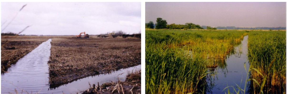
Figuur 4.3. Deelgebied in Het Twiske (de Belt) tijdens graafwerkzaamheden (maaiveld 30 cm verlaagd) januari 2004 (links) en juni 2004 (plasdras percelen, grotendeels begroeid met riet, doorsneden door sloten, rechts. Bron: Van der Hut 2004).
