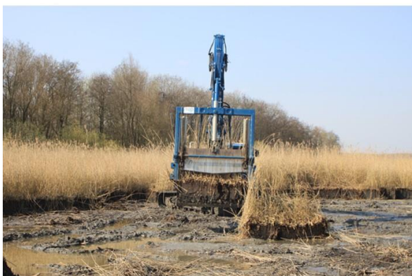
Figuur 4.18. Aanleg van rieteilanden in het Drontermeer. Gebruik van volledige rietplaggen resulteerden in goed ontwikkelde rietvelden binnen een jaar na aanleg (foto's Projectbureau IJsseldelta).
