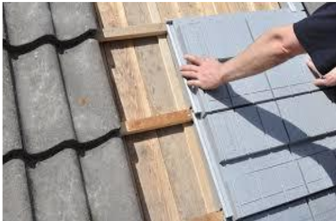
Figuur 2.8. Aanbrengen van RecaPan elementen
