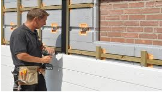
Figuur 2.17. Isolatie aan de buitenzijde.
