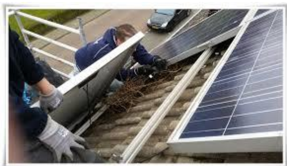
Figuur 2.18. Plaatsing van zonnepanelen op een hellend dak
