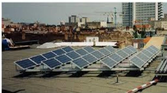
Figuur 2.19. Plaatsing van zonnepanelen op een hellend dak
