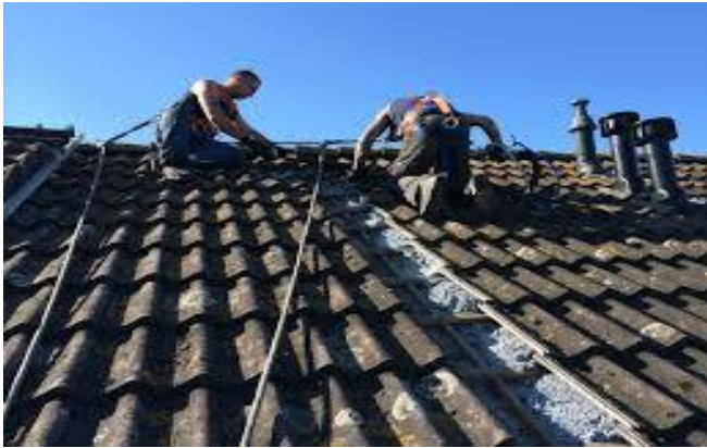
Figuur 2.7. Aanbrengen van Neopixels tussen het dakhout en de dakpannen.
