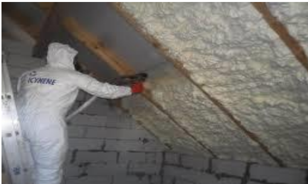
Figuur 2.6. Isolatie van binnenuit met PUR-Schuim.
