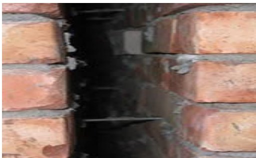
Figuur 2.10. Spouwmuur
