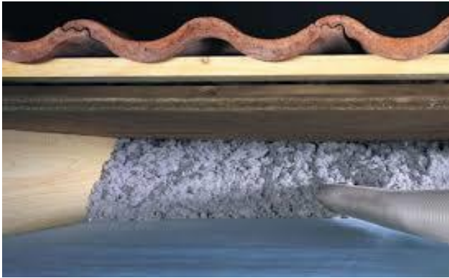
Figuur 2.5. Isolatie van binnenuit met Hennep of Cellulose.
