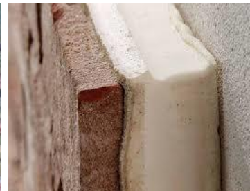
Figuur 2.15. Spouw met foam
