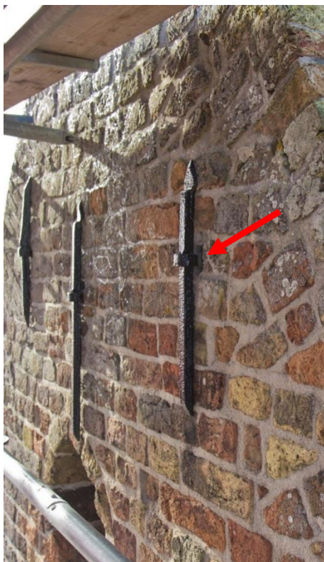
Figuur 7.4. Links een muuranker met een gat voor vleermuizen (rode pijl). Rechts de binnenzijde van een toren met de ladder tussen twee verdiepingen. Bij de overgang van de balk in de muur zit een ruimte voor vleermuizen (rode pijl). Ook zijn hier de balkgaten nodig tijdens de constructie nog goed te zien (zwarte pijl).
