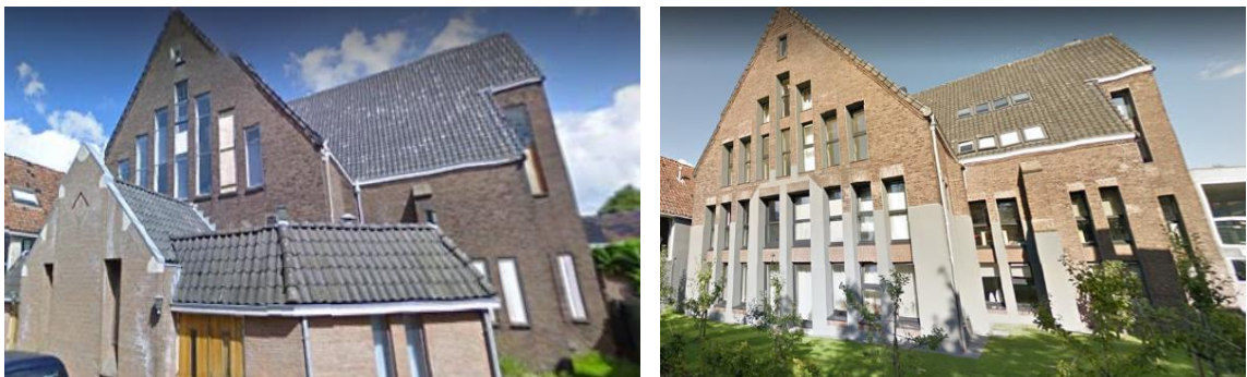
Figuur 5.1. Oosterkerk in 2010 en in 2017. werkzaamheden aan de Oosterkerk in Dokkum. De meervleermuizen zijn hierna verdwenen
