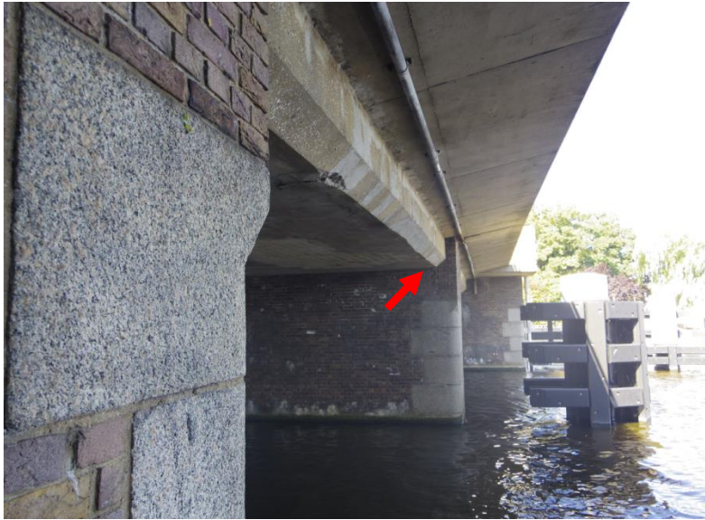
Figuur 7.5. Op de overgang tussen metselwerk en beton zitten dilatatievoegen. Hier is ruimte voor overwinterende vleermuizen.
