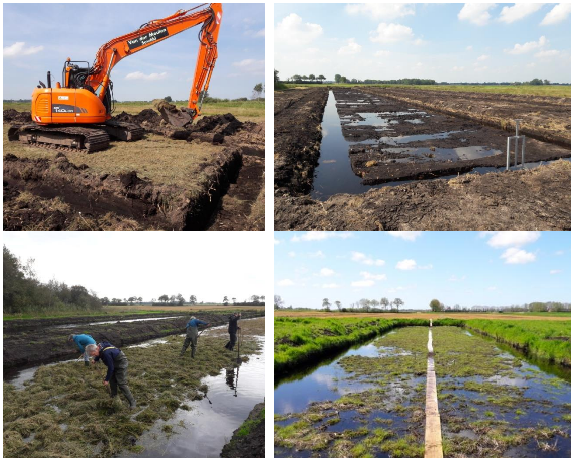
Figuur 3.5 De teeltbedden zijn gegraven eind augustus 2017, vervolgens zijn de grachten geleidelijk met water volgelopen en is eind september 2017 het maaimengsel met veenmossen ingebracht onder plasdrasse condities.
