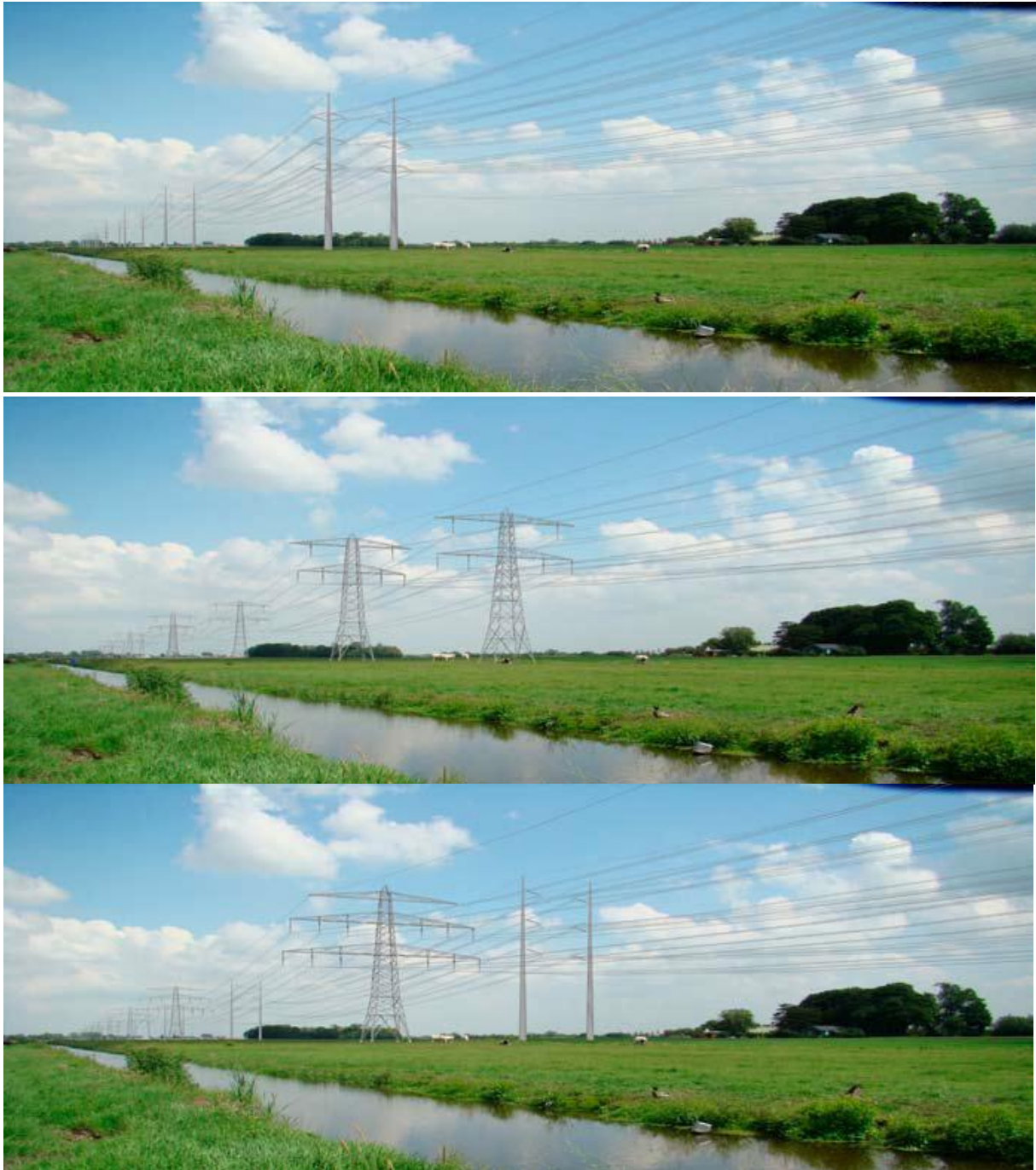
Figuur B2. Afbeeldingen (van boven naar beneden): Een gecombineerde vier-circuits bipole-mast; een twee-circuits vakwerkmast gebundeld met twee-circuits vakwerkmast; en een vier-circuits vakwerkmast gebundeld met twee-circuits bipole-mast. Bron: Startnotitie milieueffectrapportage Noord-West 380 kV.
