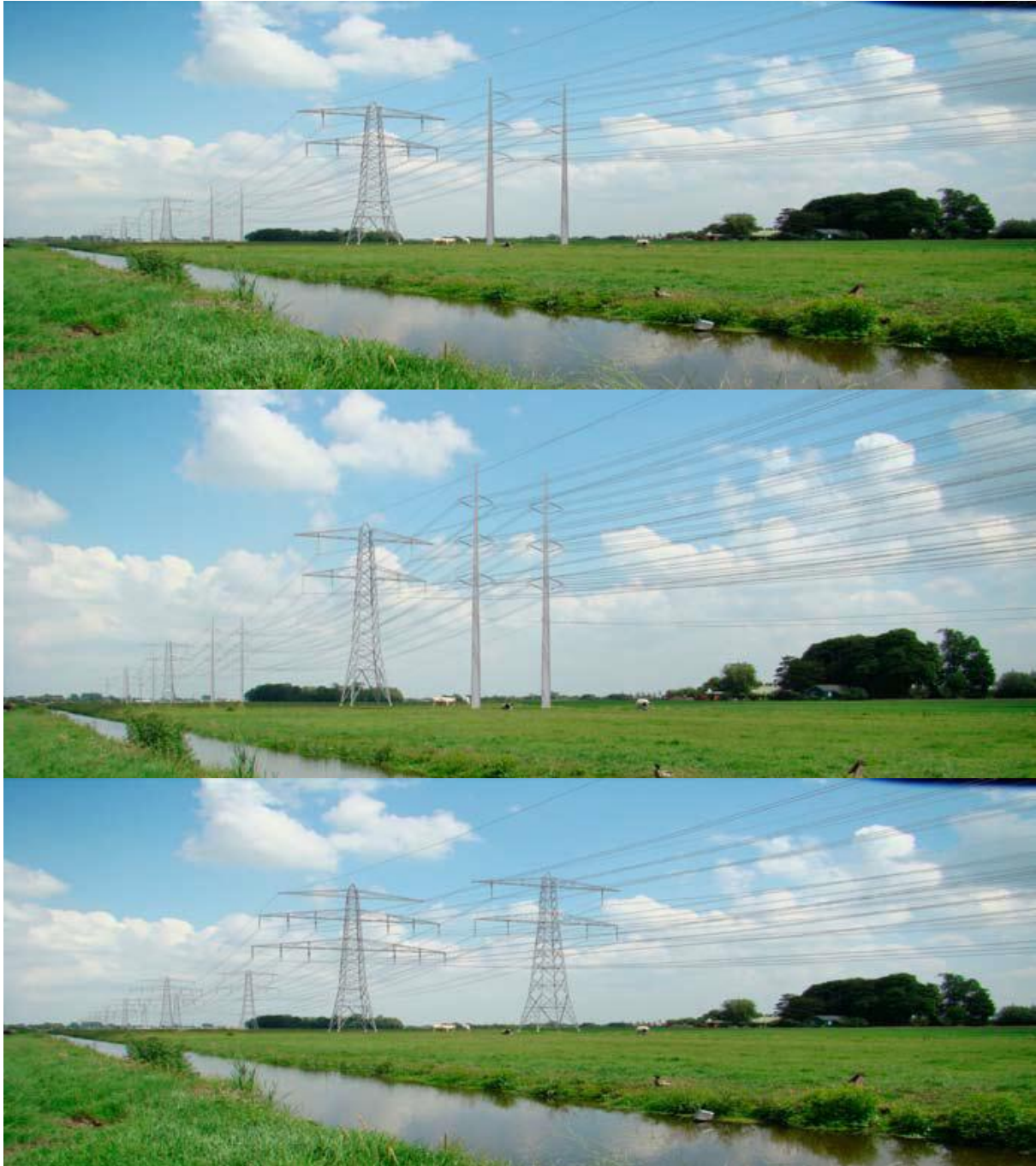
Figuur B3: Afbeeldingen van boven naar beneden: een twee-circuits vakwerkmast gebundeld met twee-circuits bipole-mast; een twee-circuits vakwerkmast gebundeld met een vier-circuits bipolemast; en een vier-circuits vakwerkmast gebundeld met twee-circuits vakwerkmast. Bron: Startnotitie milieueffectrapportage Noord-West 380 kV.
