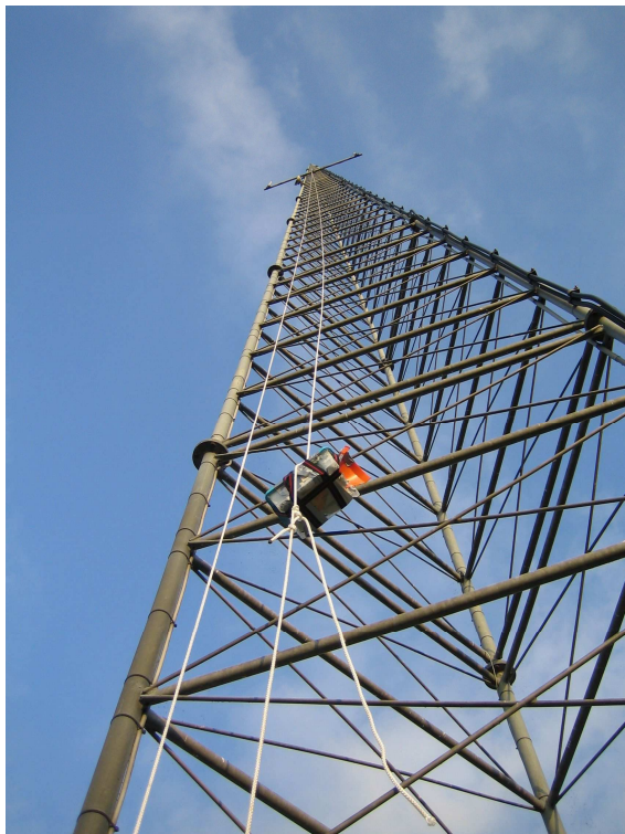
De zendmast met daaraan een katrol en een lang touw waarmee een luisterkistje omhoog getakeld kon worden.
