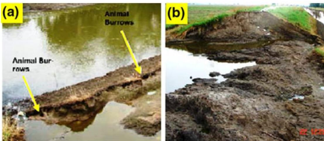
Foto's: Restanten van de doorgebroken Pin Oak Levee bij Winfield Missouri, waarbij in een ochtend in 2008 plotseling 150 huizen overstroomden. Foto's uit: Bayoumi & Meguid (2011).
