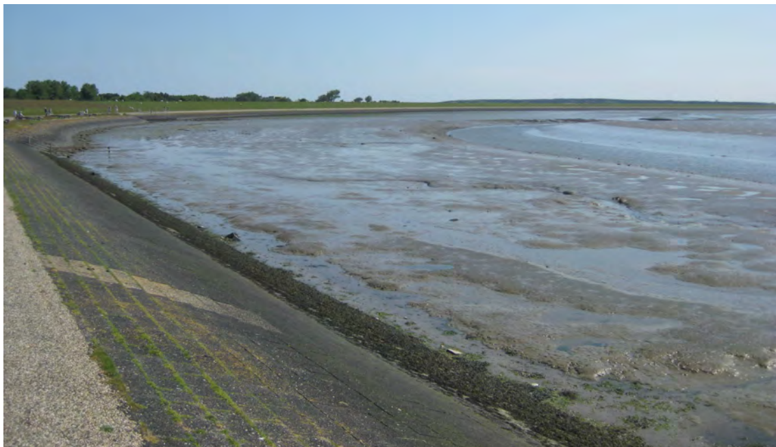
Dijklichaam met droogvallend wad aan de buitenzijde ter hoogte van de Ballumerbocht. A&W, zomer 2009.
