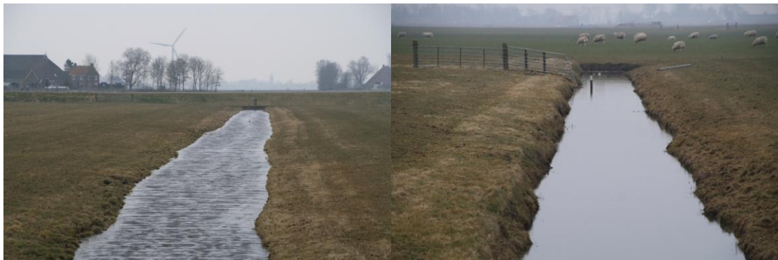
Foto 2-2 - Hoogwatersloot (links) en laagwatersloot (rechts) op de proeflocatie Wommels in het voorjaar van 2011 (foto A&W)
