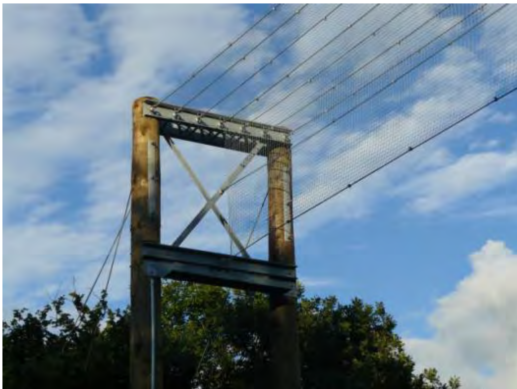
Figuur 4-5 - De onderzochte kunstmatige hop-over bij Groeslon. Dit betreft een T-vormige gaasconstructie ('wired fence') over de A 487 van 2 meter breed en 2 meter hoog.
