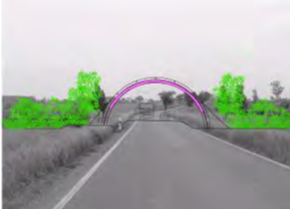
Figuur 1-1. Impressie van een kunstmatige hop-over: kunstmatige stellage over de weg, gepositioneerd in het verlengde van een singel. (Bron: Brinkmann et al. 2008).
