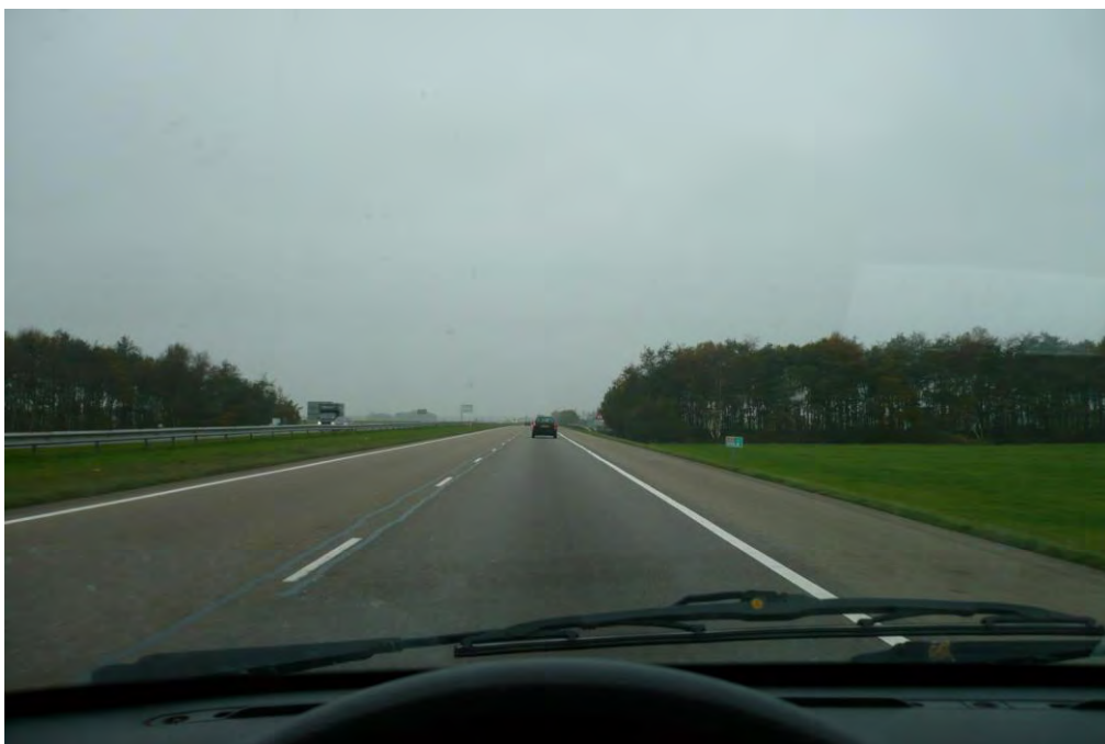
Figuren 3-3 en 3-4 De bovenste foto laat de Lietsweg bij Marum (locatie 7, zie figuur 3-1) zien. Dit viaduct is aangepast, zodat een groenzone over de A7 wordt geleid. Dit is een voorbeeld van een ecoduct. Tevens is een geleidende structuur in de vorm van houten schotten aan de zijkant van de overspanning zichtbaar. De onderste foto laat locatie 1 (Haulstersingel, zie figuur 3-1) zien, waar geen hop-over aanwezig is. Vleermuizen passeren de weg 'koplamphoogte', met grote kans op aanrijdingen.
