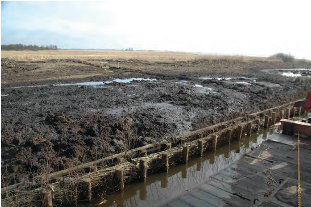
Dubbele palenrij met wilgentenen t.b.v nieuwe vooroevers (De Wieden, 2009).
