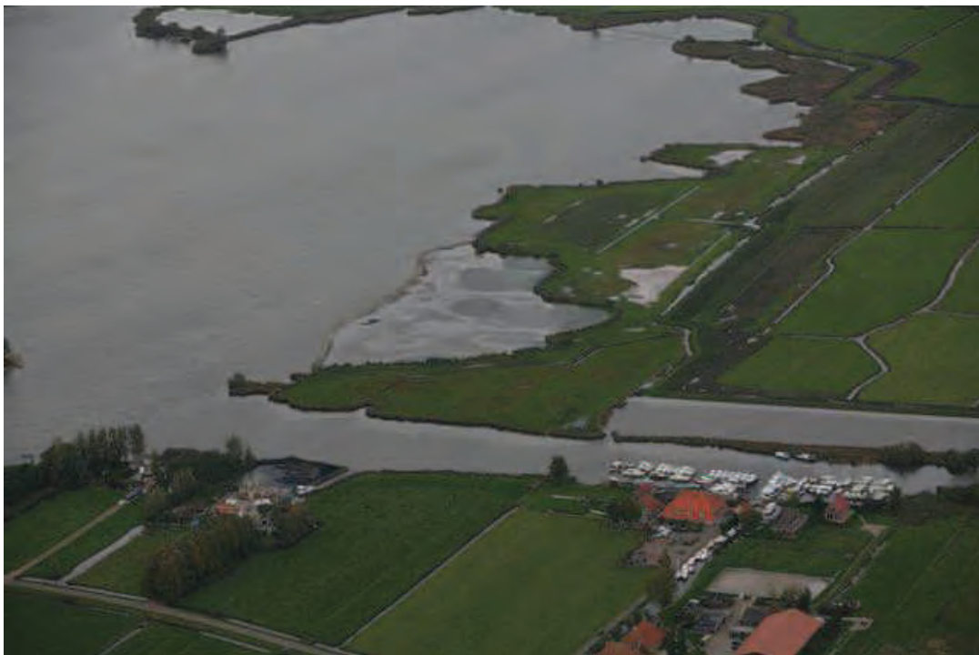
Luchtfoto van een geotube (De Pine bij Heeg, 2010).
