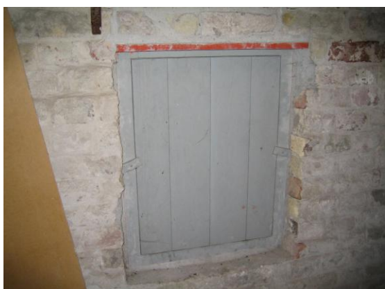
3C. Een goed sluitend luik tussen de toren en de zolder van de kerk (foto A&W).
