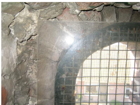
3A. Een toren gat met gaas en plexiglas om vogels buiten te houden.
