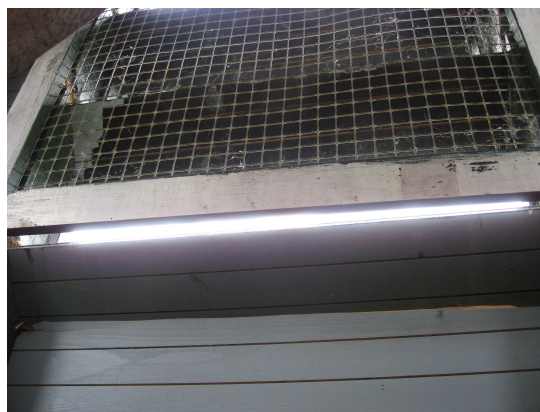
3B. Gaas dat niet heel nauwkeurig is geplaatst geeft vleermuizen de gelegenheid om alsnog binnen te komen.
