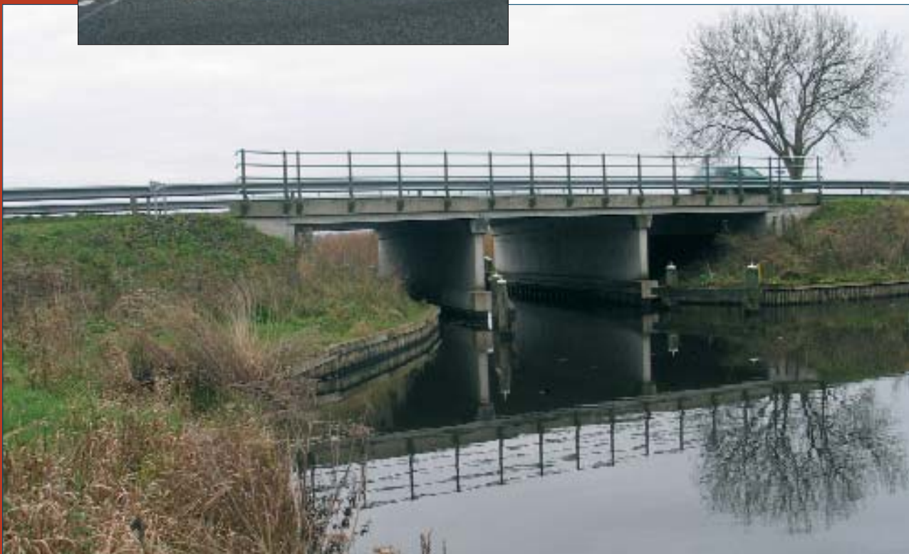
De brug in de N333 over de Roomsloot.
